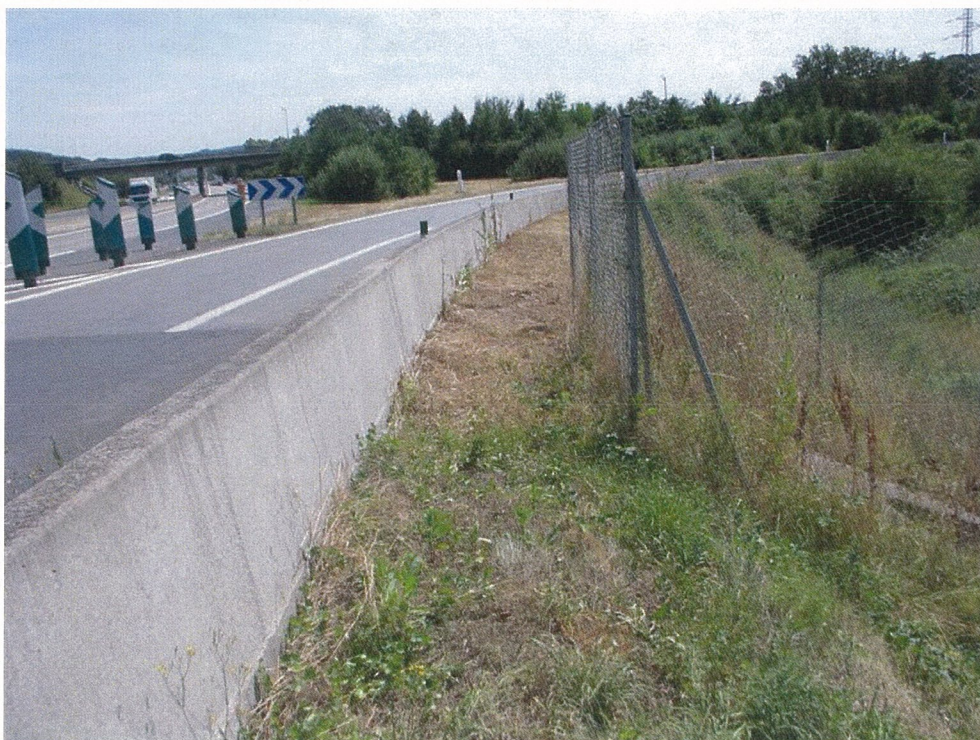
Photo n°14 : Accotements Ouest non revêtus (interfaces entre les glissières de la voie portée et les têtes de buse).
