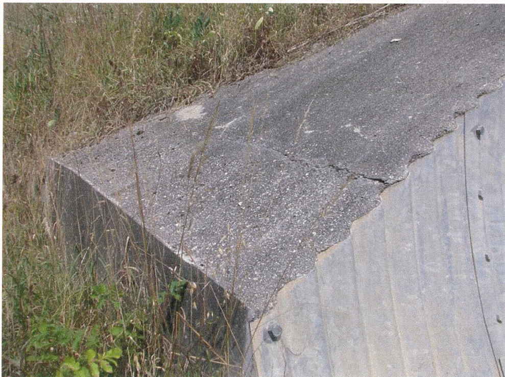
Photo n°8 : Tête de buse Ouest : Fissuration du béton côté Nord.
