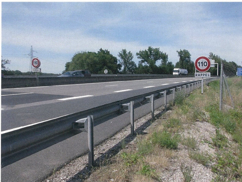
Photo n°13 : Accotements Est non revêtus (interfaces entre les glissières de la voie portée et les têtes de buse) .
