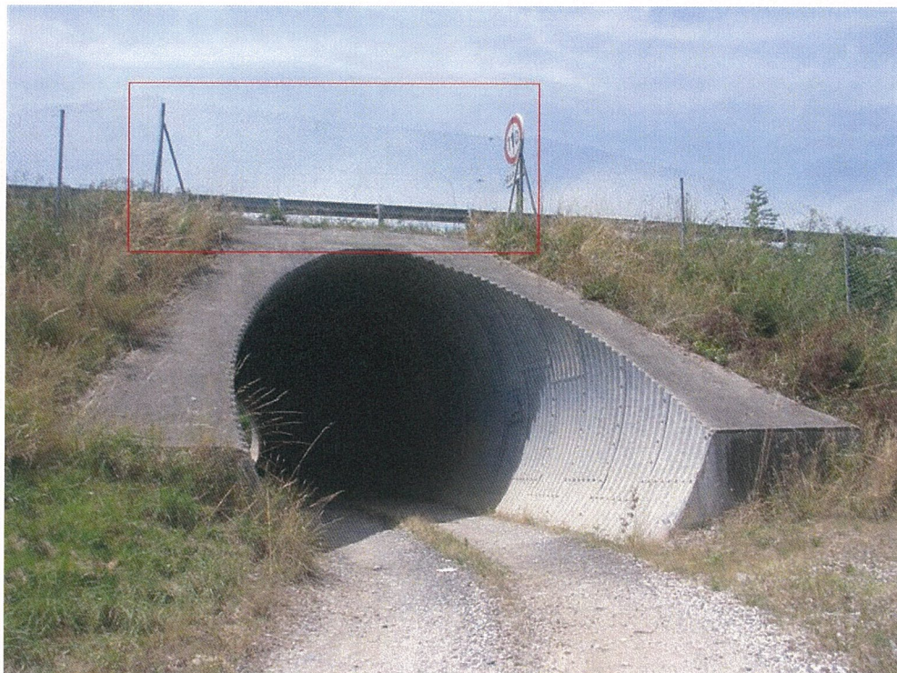
Photo n°15 : Absence d'un poteau de soutien du grillage en tête de buse (côté Est).
