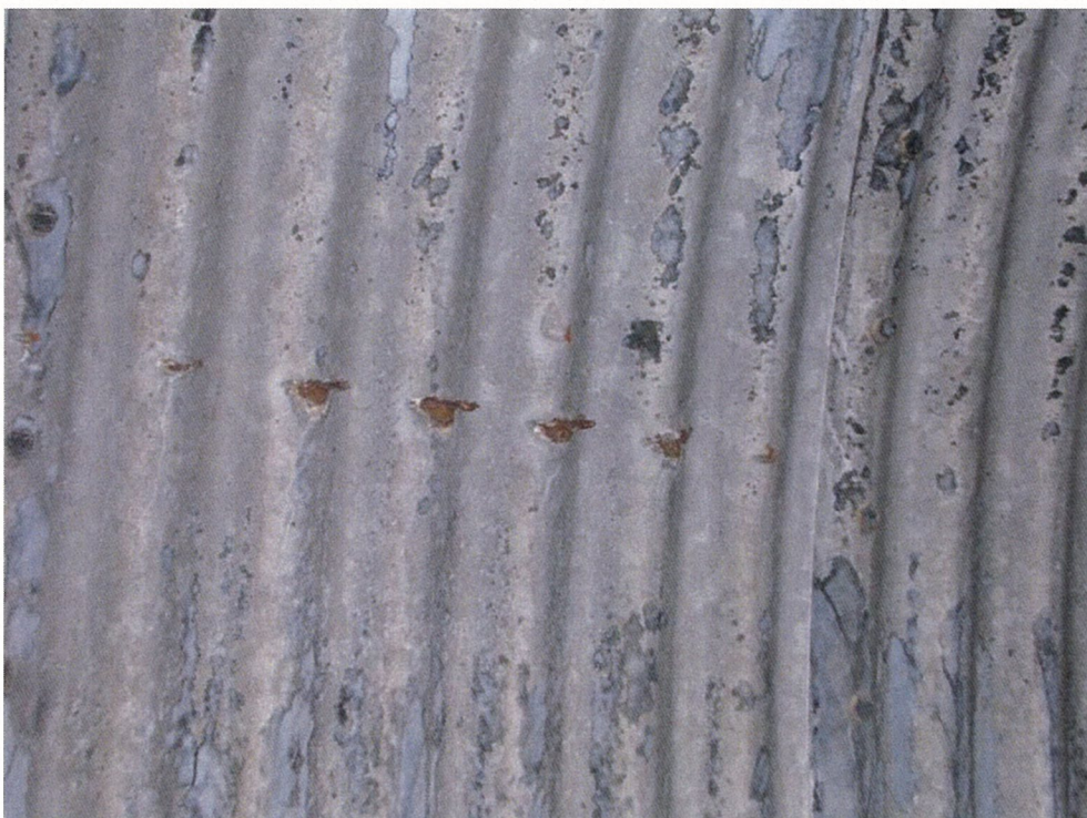
Photo n°2 : Plaque présentant des traces de chocs et des déchirures (profil 20 m).
