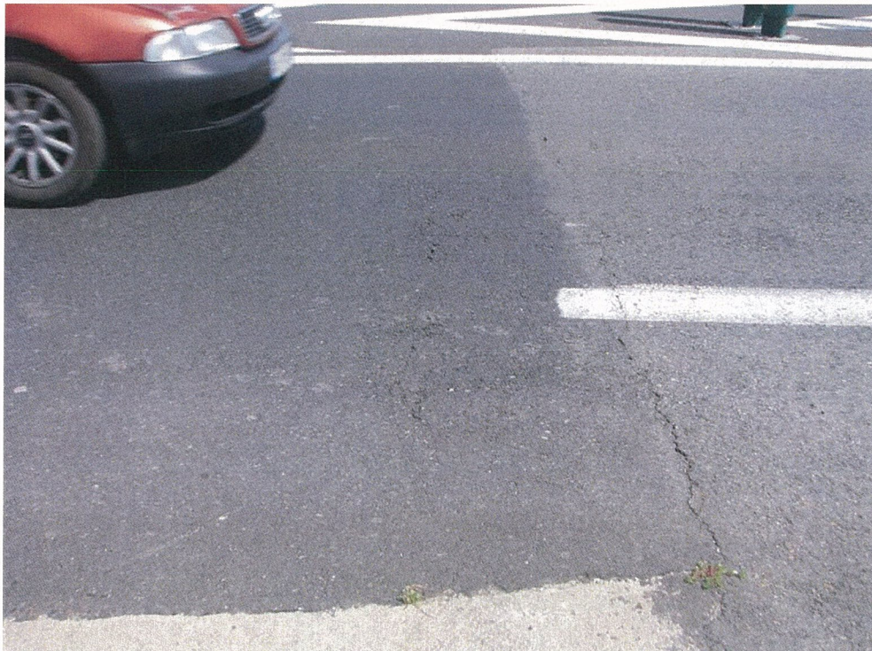
Photo n°10 : Voie portée sens Nord-Sud : Fissuration transversale (reprise d'enrobé).
