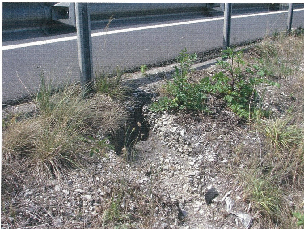
Photo n°11 : Accotement de la voie portée – sens Sud-Nord : Affouillements liés à l'absence de guidage des EP au niveau du fil d'eau.
