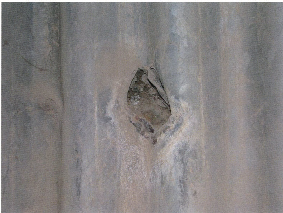
Photo n°1 : Plaque perforée sur environ 10 cm au profil 27 m (impact).
