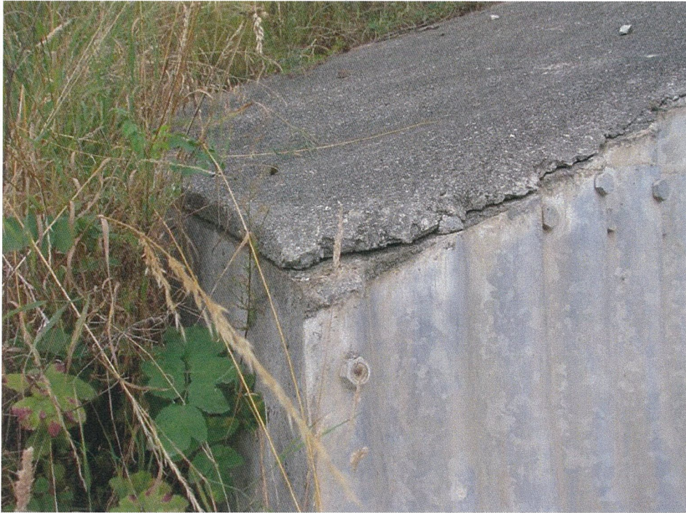
Photo n°9 : Tête de buse Est : décollement localisé du renformis côté Sud.
