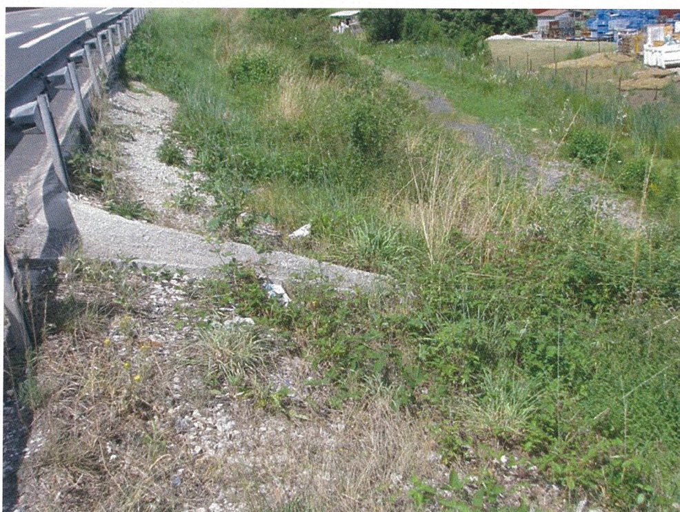
Photo n°12 : Présence de végétation parasite dans la descente d'eau située sur l'accotement côté Nord-Est (sens Sud-Nord).
