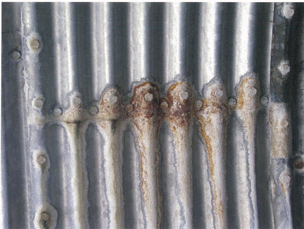
Photo n°5 : Corrosion des plaques et de la boulonnerie (détail au profil 42 m côté sud).
