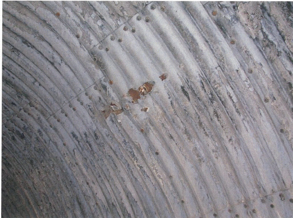
Photo n°3 : Zone bombée vers l'intérieur avec des déchirures au profil 21 m côté Sud.
